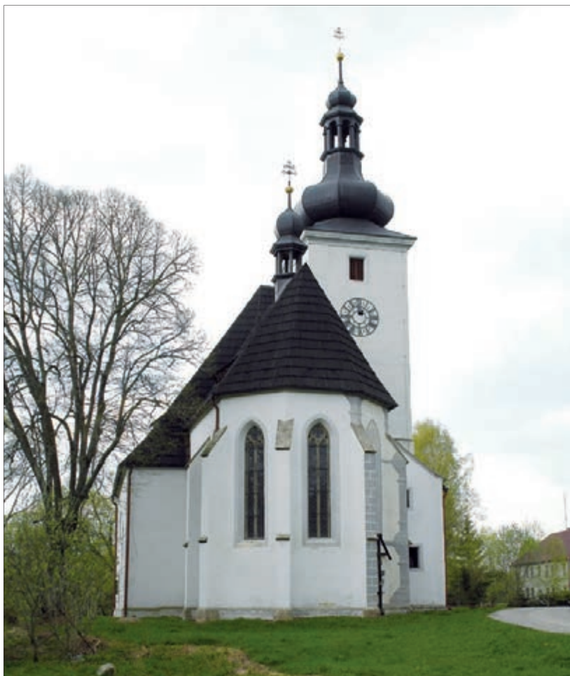
Cetviny (okres Český Krumlov), pozdně gotický kostel po rekonstrukci. Foto 2006.
