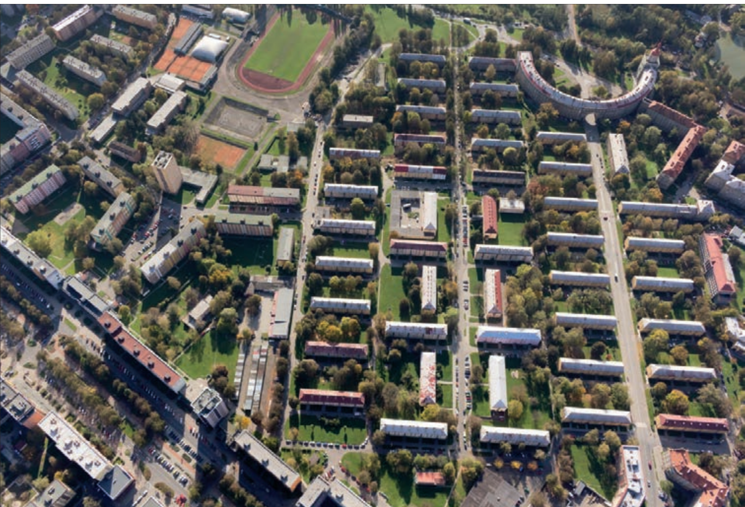
Poruba (okres Ostrava-město). Poválečné sídliště Dvouletky bylo krátce po dokončení zakomponováno do nového „socialistického“ města Poruby ve stylu socialistického realismu a spolu s ním je od roku 2003 součástí městské památkové zóny. Foto Jakub Karas (UPVISION) 2014.
